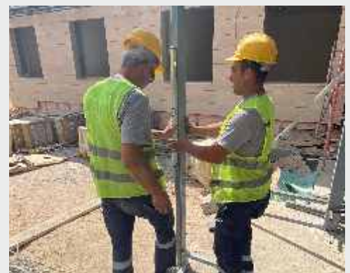
Field Assembly / Saha Montajı
